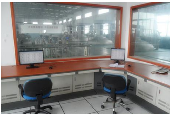
DCS 离散分布式控制系统 90° 转角全透明监控室
